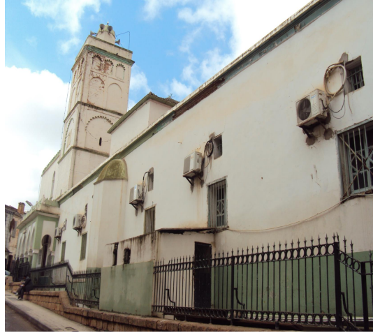
الصورة رقم (22): الواجهة الجنوبية الشرقية للجامع الكبير
