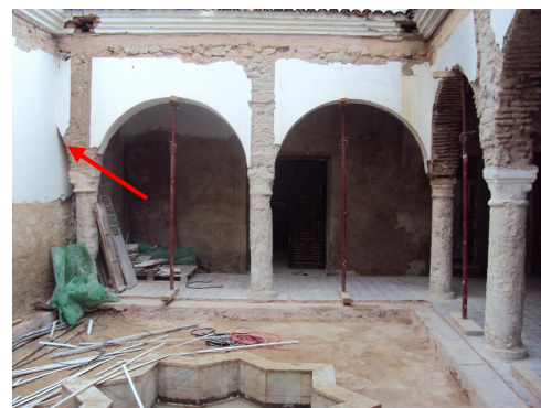
الصورة رقم (116): فناء المحكمة ورواقها الجنوبي خلال عملية الترميم الثاني
