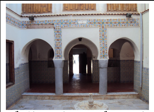
الصورة رقم (93): الرواق الشرقي في دار الباي بعد عملية الترميم الأولى
