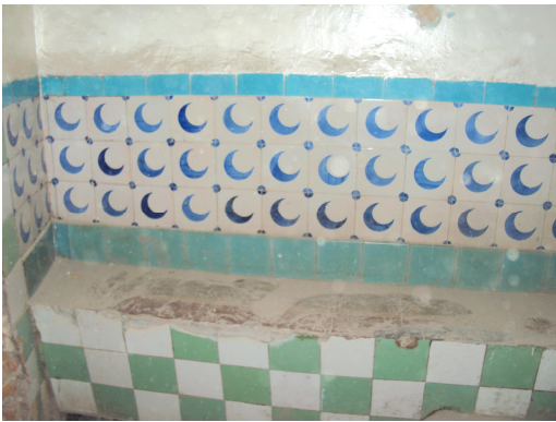
الصورة رقم (148): قاعة الانتظار الثانية بحمام حمزة
