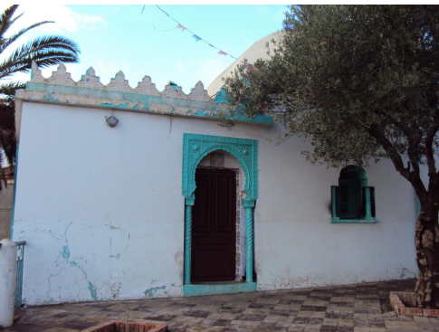
الصورة رقم (82): المءءل الرئيسي لضريح سيدي أحمد بوجلل
