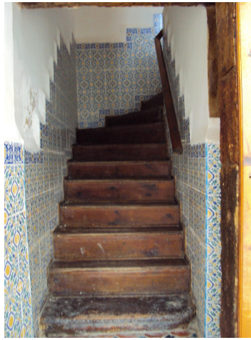
الصورة رقم (123): سلم المحكمة بعد الترميم الأول
