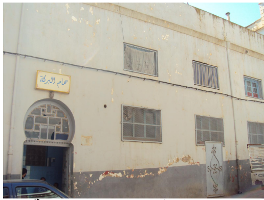
الصورة رقم (125): الواجهة الرئيسية لحمام البركة
