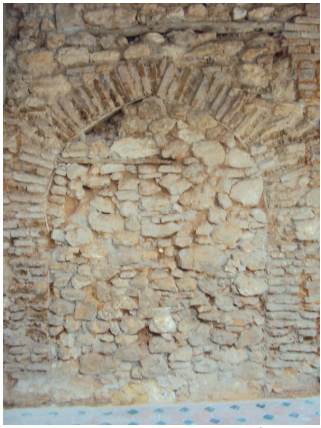
الصورة رقم (124): الشكل الأصلي لأبواب الحجرات المحكمة يظهر خلال عملية الترميم الثانية وهو مسدود
