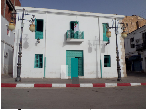
الصورة رقم (114): المحكمة الرئيسية بعد الترميم الثاني
