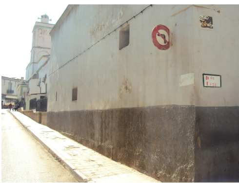
الصورة رقم (127): الواجهة الجنوبية الشرقية لحمام البركة
