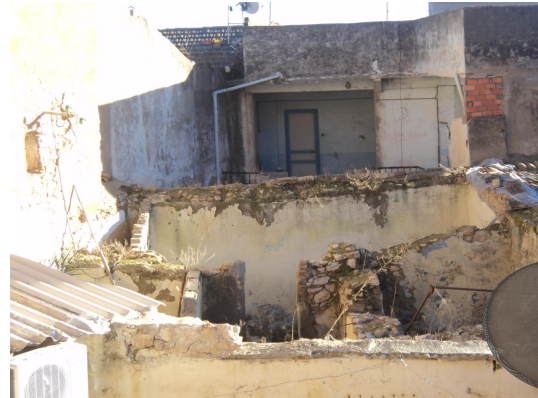
الصورة رقم (142): مخزن الحطب بحمام القرشالي
